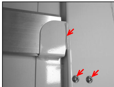
Poche d'insertion sur poteau d'angle
